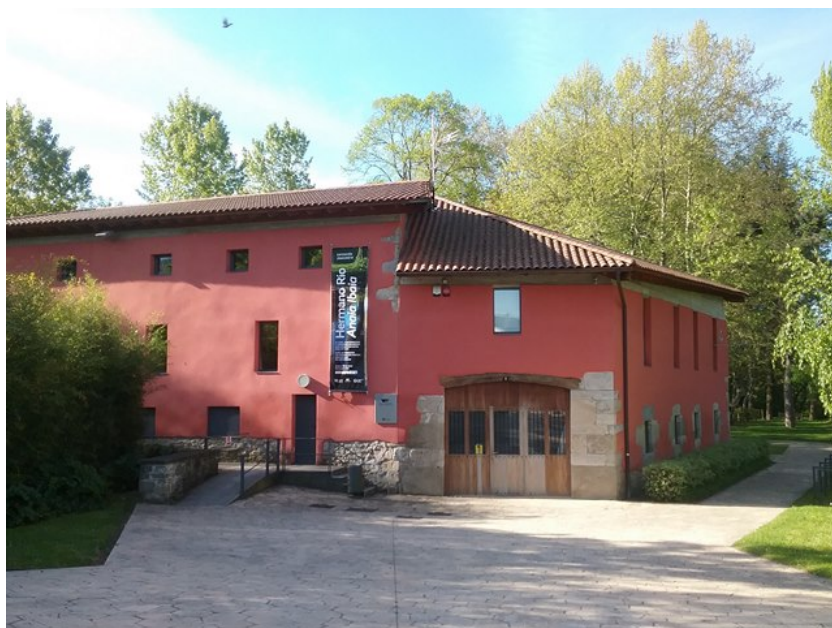
Fachada y acceso
